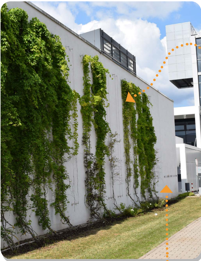
Bodengebundene Fassadenbegrünung mit Rankhilfe © Bundesverband GebäudeGrün e. V.
